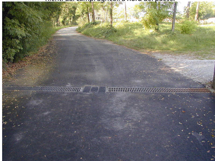
Via Marchian Nuove griglie supplementari per catturare le acque piovane provenienti dai campi agricoli a nord del paese.
