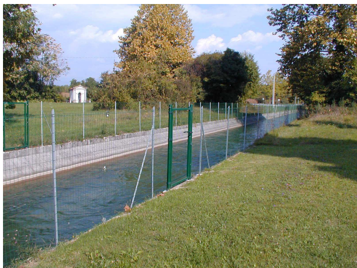
Canale Maraldi all'altezza della Chiesetta di San Rocco Recinzione di protezione su ambo i lati
